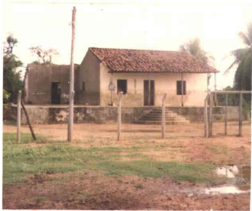
FOTO - 06: Área de projeto: casa de tijolo típica da área.
