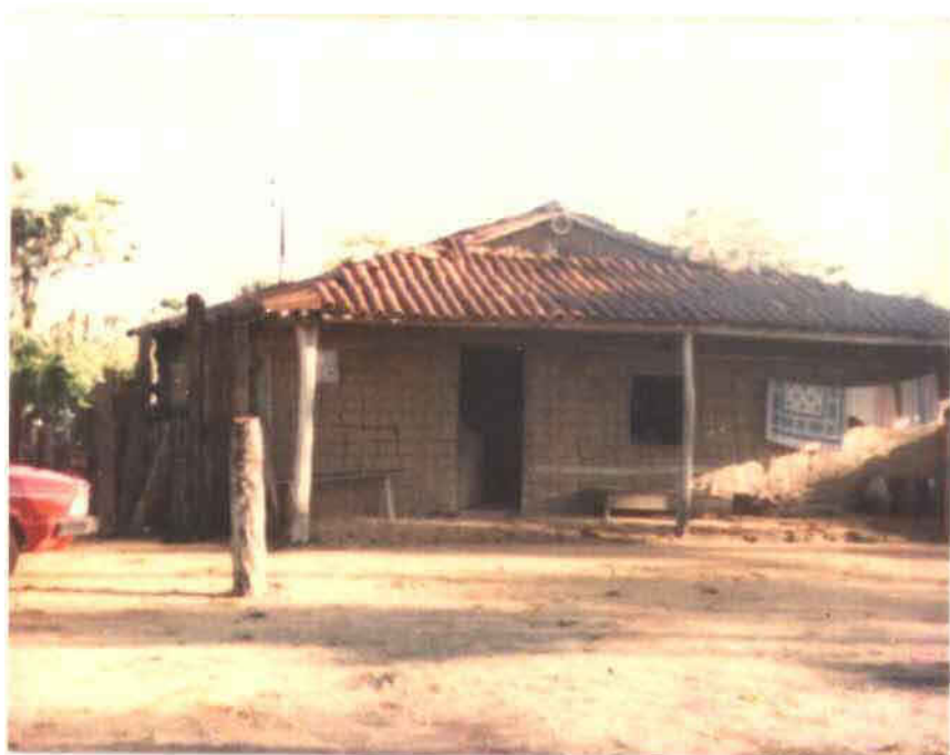
FOTO - 05: Área de projeto: casa de taipa típica da área.
